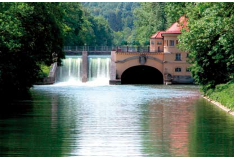
Wasserkraftwerk Isar 1 in München
